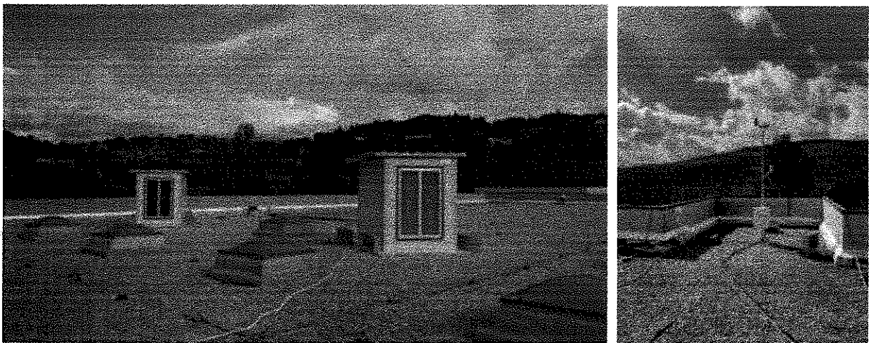
Fig. 1: un'immagine del campo sperimentale C.A.S.E.T.T.E. (Coupled Advanced Systems for Experimentation on Translucent and Thermal-insulated Envelopes) posizionato sul tetto del biennio del Polo di Ingegneria di Perugia; a destra la centralina per la misura delle grandezze meteo.
